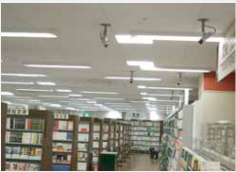
▲南大沢店の防犯カメラ設置風景。売場を取り囲むように奥側から映す手法をとっている。
