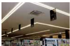
LED照明でエコな店づくり実施！
