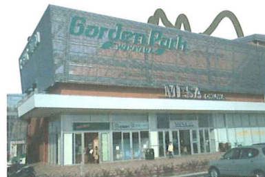
敷地面積17,961坪、延床面積4,676坪。
